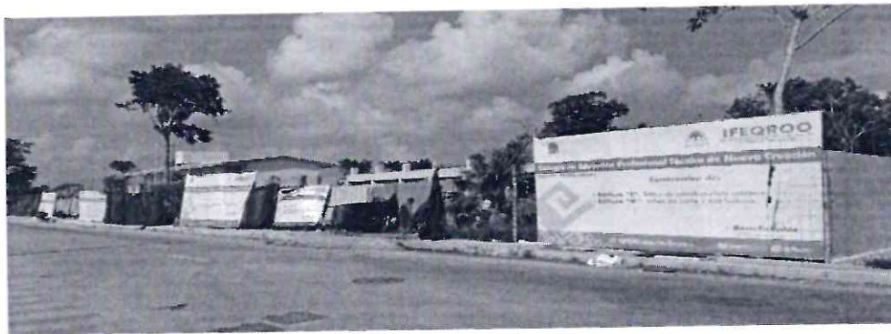
Fachada (provisional) del Plantel CONALEP Cancún IV
