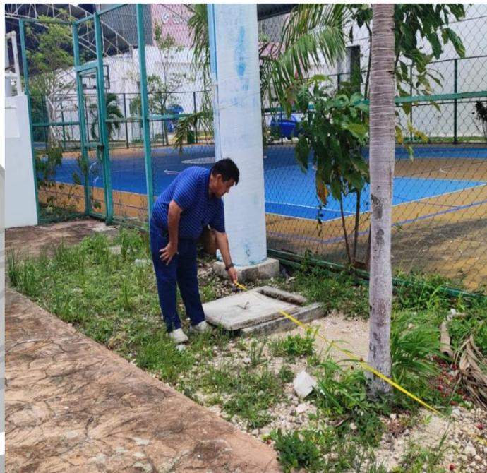
En el área de línea de conducción sanitaria se pudo observar residuos de material producto del afine de y detallado de pozos por lo que se le solicito a la empresa contratista atender a la brevedad la limpieza a detalle esto con el objeto de no tener interferencia laguna en el flujo dentro de las tuberías que conducen las aguas residuales hacia la PTAR.
