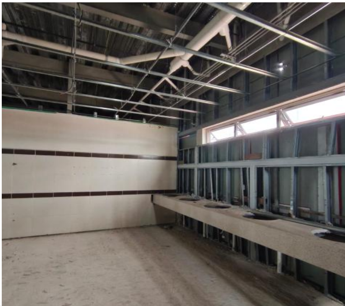
Se continua con los trabajos de rehabilitación de muros de tablaroca y elaboración de mamparas en al área de servicios.
