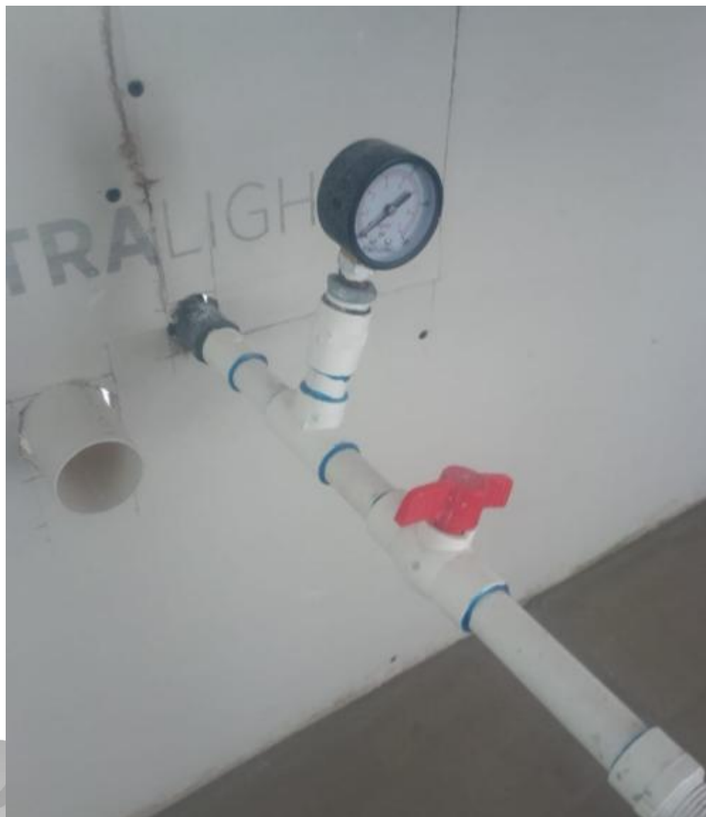
Se verificaron las pruebas de hermeticidad en ramales de tubería hidráulica.
